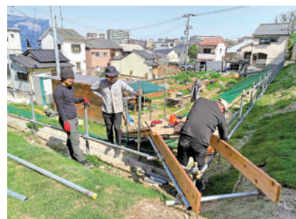
階段の施工(下に農園が広がる)
