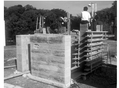
図-7 版築造実験居室建設風景
