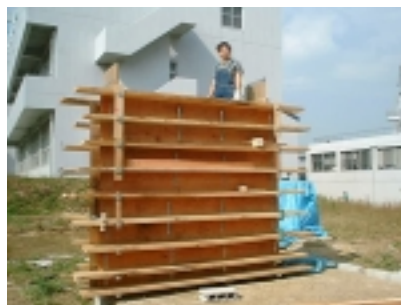
図-4 ひと壁打ち終わった状態
